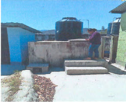
Foto 1: Mejoramiento de depósito de agua
