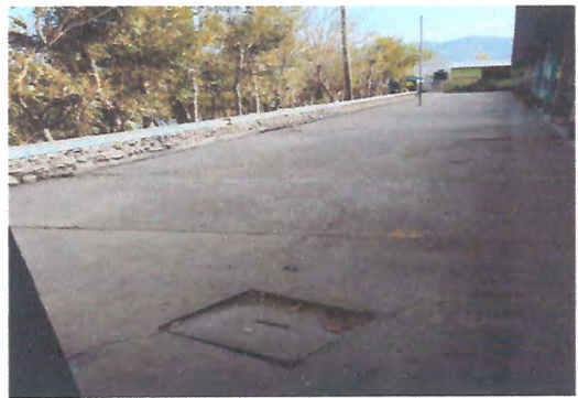
Foto 4: Mantenimiento losa de patio
