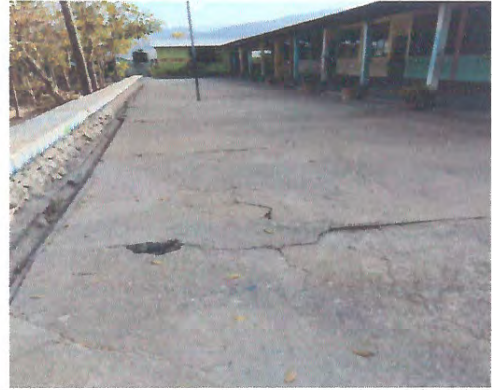
Foto 2: Mejoramiento de losa de patio
