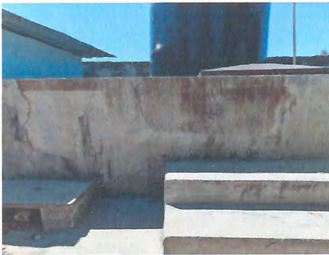
Foto 3: Mejoramiento de depósito de agua
